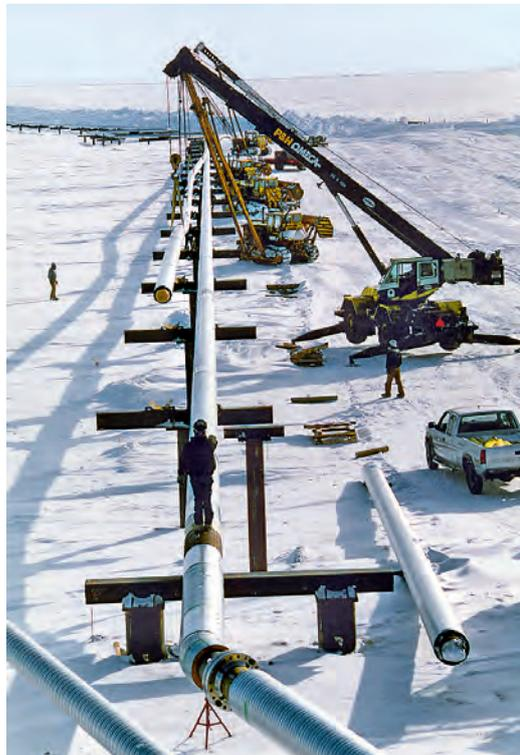
**Verlegung isolierter 24-Zoll-Rohre aus dem Werkstoff EN 1.4462 (2205) auf vertikalen Stützen in Prudhoe Bay (Quelle: Arco Exploration and Production Technology)**
