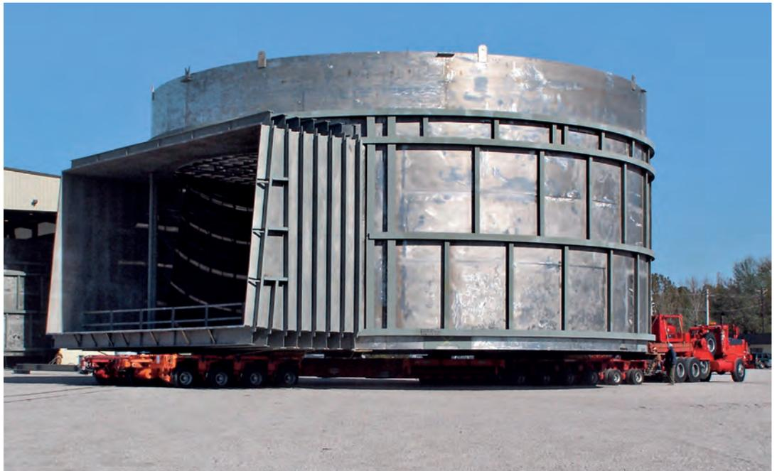
Rauchgasentschwefelungsanlage aus dem Stahl EN 1.4462 (2205); (Quelle: Aperam)
