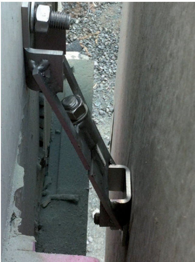
Bild 10: Befestigungssysteme aus nichtrostenden Stählen bestehen langfristig auch bei Dauerfeuchtigkeit und in nicht zugänglichen Bereichen von Fassaden, Treppen, Tunneln und Brücken und bieten so größtmögliche Sicherheit (Foto: W. Modersohn GmbH & Co. KG, Spenge)
