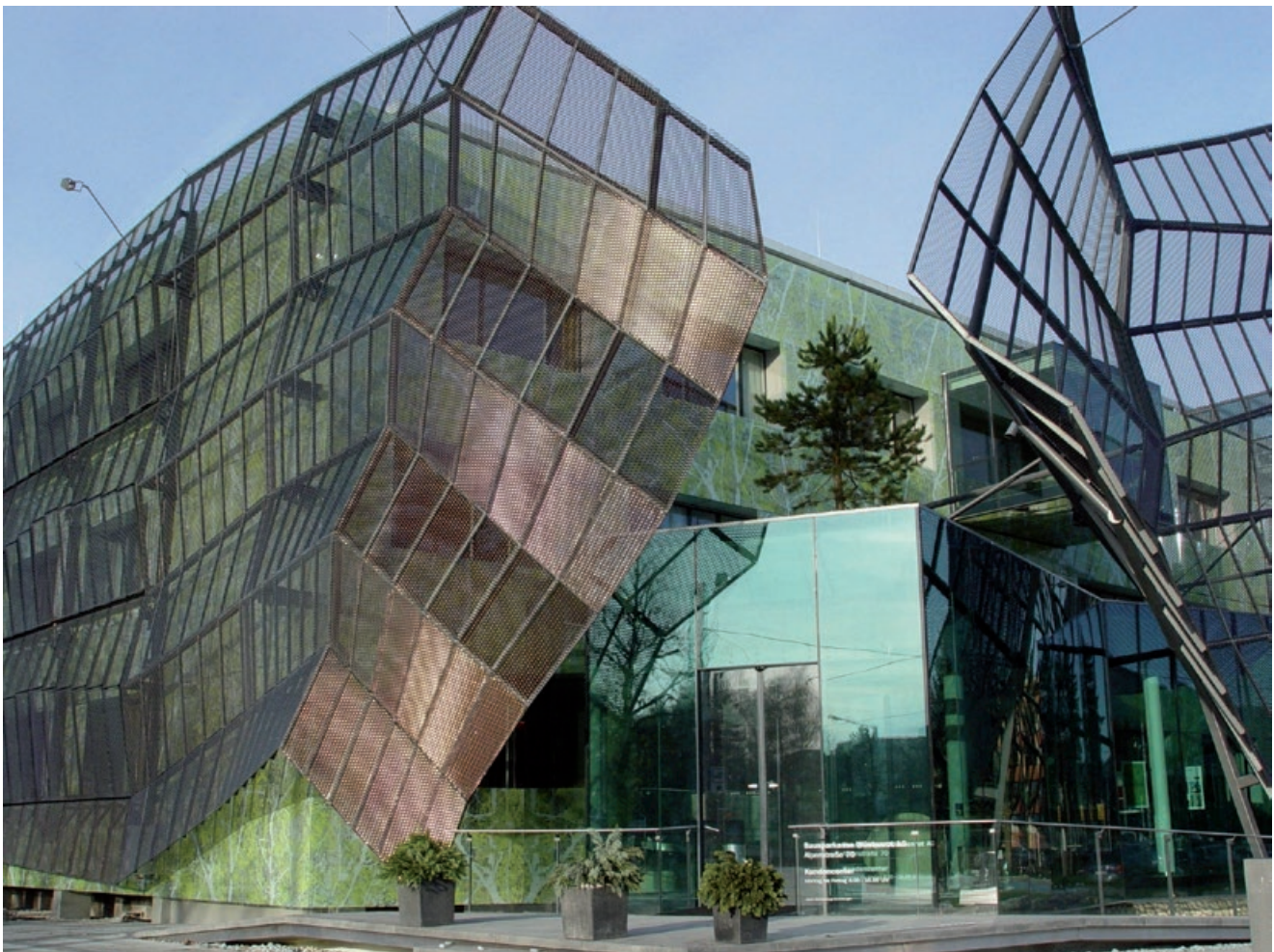
Bild 9: Ein Sonnenschutz aus elektrolytisch eingefärbtem nichtrostendem Streckmetall verleiht auch schlichten Gebäuden eine besondere Optik (Foto: Inox-Color GmbH & Co. KG, Walldürn)
