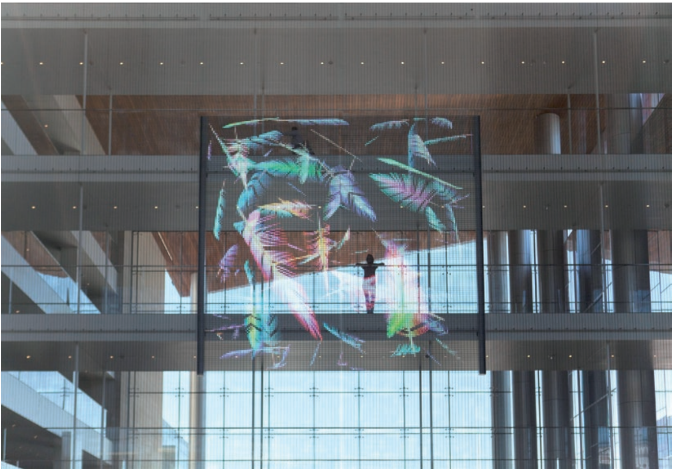
Bild 8: Medienfassaden aus nichtrostendem Drahtgewebe mit integrierten LEDs können beliebig ferngesteuert werden – mal als vollflächige Werbefläche oder als Videowand oder, wie hier, für künstlerische Darstellungen. So tragen sie zur lebendigen Gestaltung von Außen- wie Innenräumen bei (Foto: Gebr. Kufferath AG, Düren)
