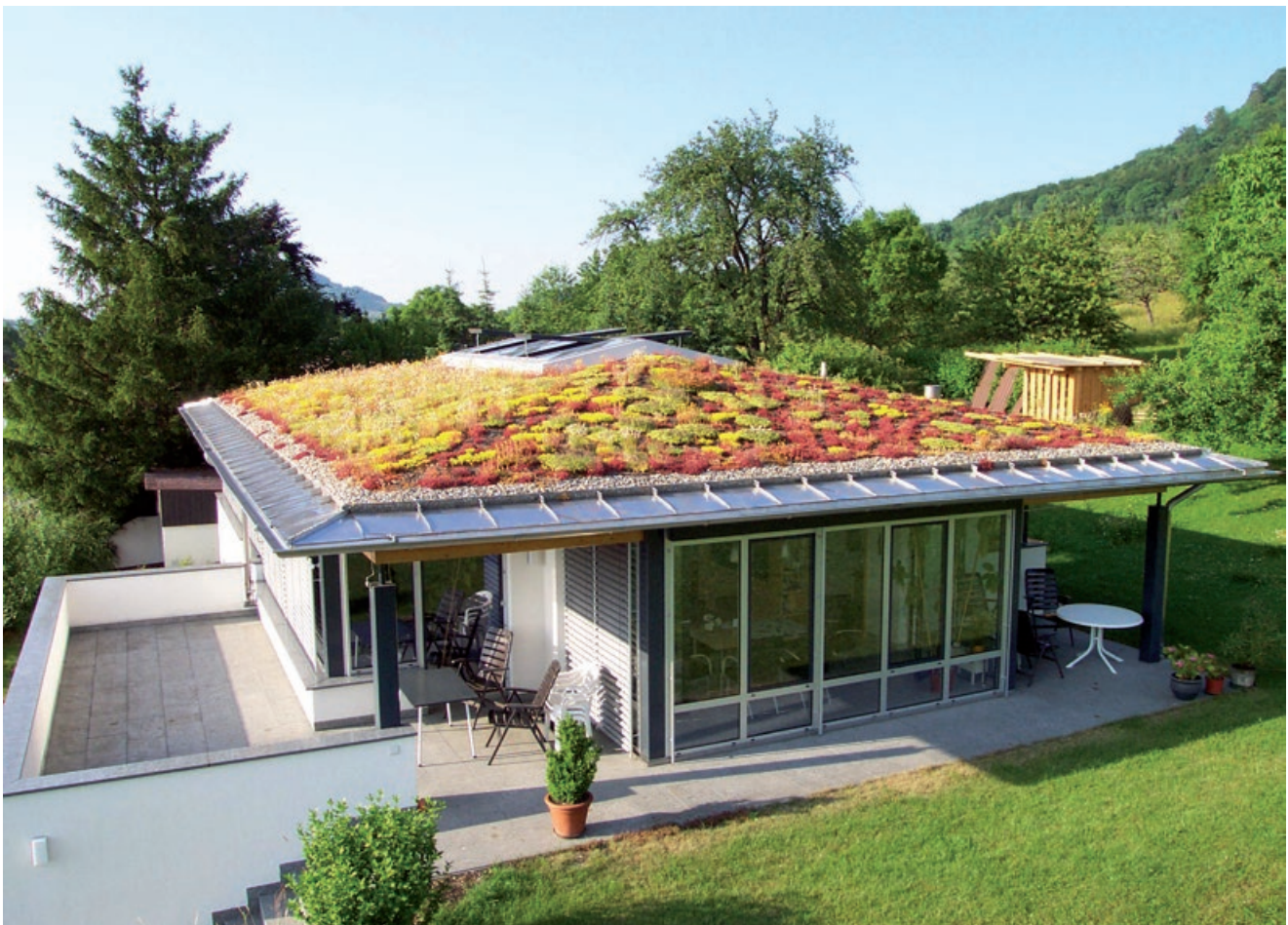
Bild 6: Dächer aus Edelstahl Rostfrei sind korrosions- und witterungsbeständig, dauerhaft dicht sowie durchwurzelungsfest, so dass sie sich besonders für die Dachbegrünung eignen: Das verbessert das Klima außer- und innerhalb von Gebäuden (Foto: Optigrün international AG, Krauchenwies-Göggingen)
