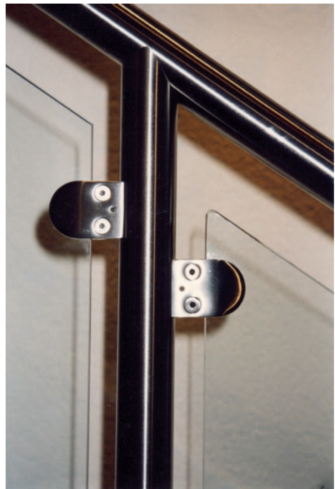
Bild 7: Leicht lösbare Verbindungen erhöhen die Wiederverwendungsfähigkeit von Bauteilen aus Edelstahl Rostfrei (Foto: Schlosserei Singler GmbH, Griesheim)
