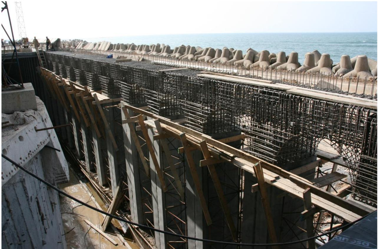
Mehr als 1200 Tonnen Duplexstahl wurden von UGITECH geliefert, um die Instandsetzungsarbeiten auszuführen (hier die Bewehrung der Stahlbetonplatte) (Foto: Christine Raynaud)
