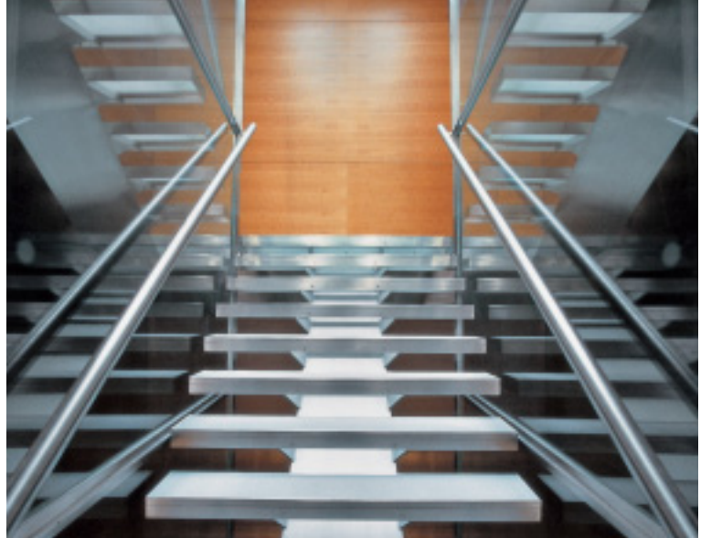
Die frei tragende Mittelwange und die aufgeständerten, durchscheinenden Glasstufen lassen die Treppe leicht und offen wirken.
