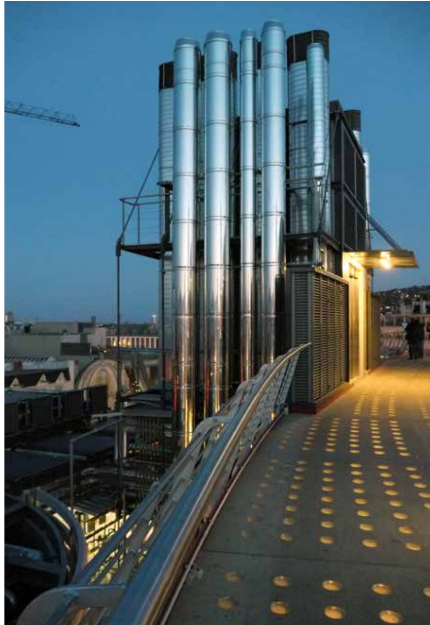
Bild 20: Abgasanlagen unterliegen harmonisierten europäischen Normen. Foto: Thomas Pauly, Brüssel (B)
