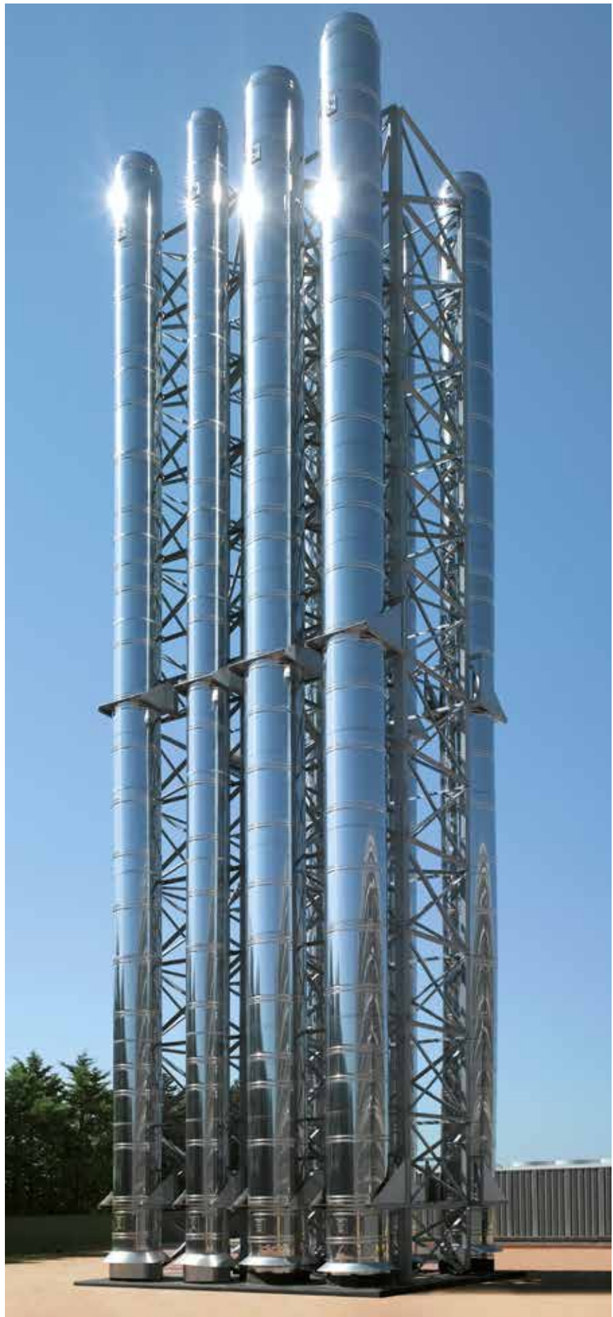
Bild 22: Seine Kombination von Korrosions- und Hochtemperaturbeständigkeit macht nichtrostenden Stahl zu einem optimalen Werkstoff für leichte und elegante Abgasanlagen. Foto: Roccheggiani, Camerano, Ancona (I)
