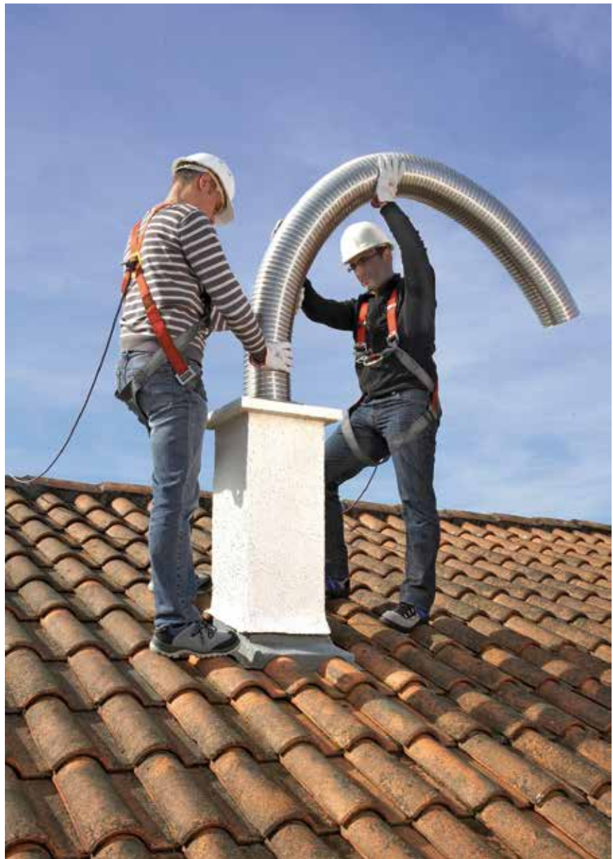
Bild 13: Flexible Kamineinzugsrohre sind besonders verbreitet, weil sie sich schnell und kostengünstig einbringen lassen. Foto: Poujoulat, Saint-Symphorien (F)
