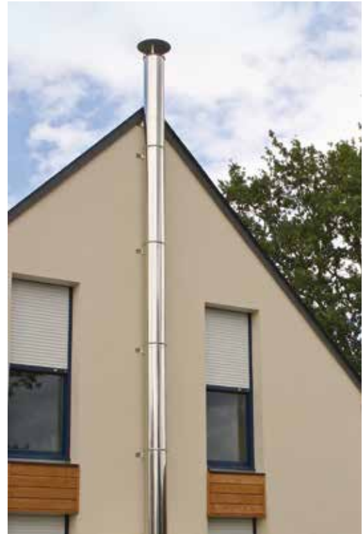
Bild 7+8: Doppelwandige wärmegeädämmte Abgasanlagen im Außenbereich (oben) erzielen einen ebenso guten Kaminzug wie klassische, durch den Gebäudekörper verlaufende Schornsteine (unten). Fotos: Poujoulat, Saint-Symphorien (F)
