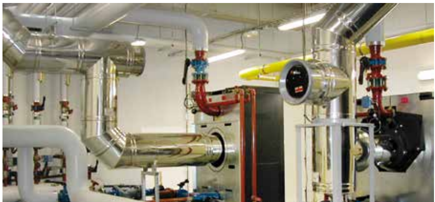
Bild 2: Abgasleitungen aus nichtrostendem Stahl sind gegen saure Kondensate, wie sie bei Brennwertkesseln entstehen, beständig. Foto: Poujoulat, Saint-Symphorien (F)
