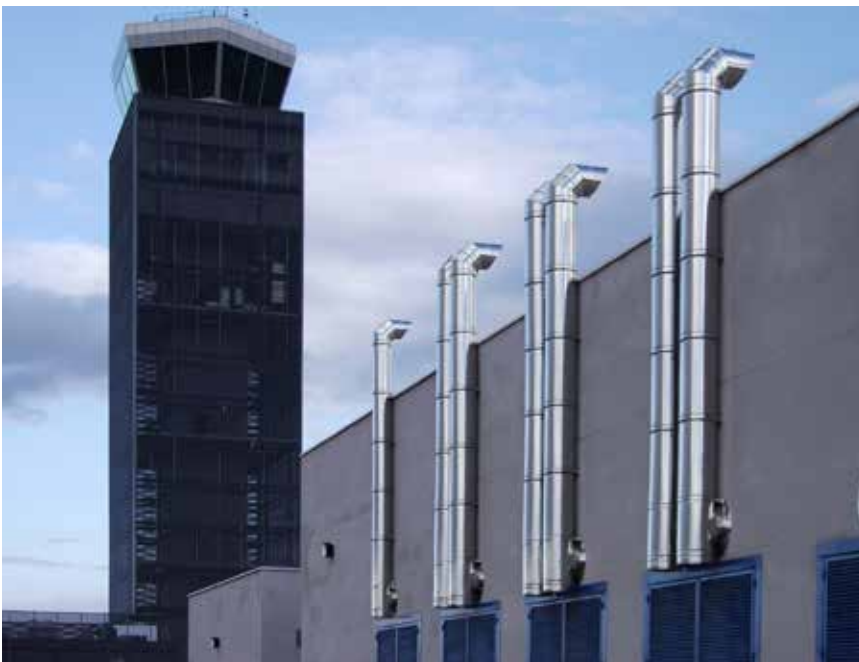
Bild 5: Abgasanlagen können auch der gestalterischen Aufwertung öffentlicher Gebäude dienen. Foto: Dinak, Vigo (E)
