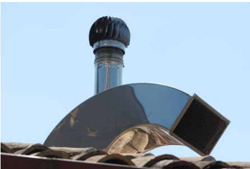
Bild 18: Neben Abgasanlagen aus nichtrostendem Stahl werden häufig auch Lüftungseinrichtungen aus demselben Material eingesetzt. Foto: Thomas Pauly, Brüssel (B)
