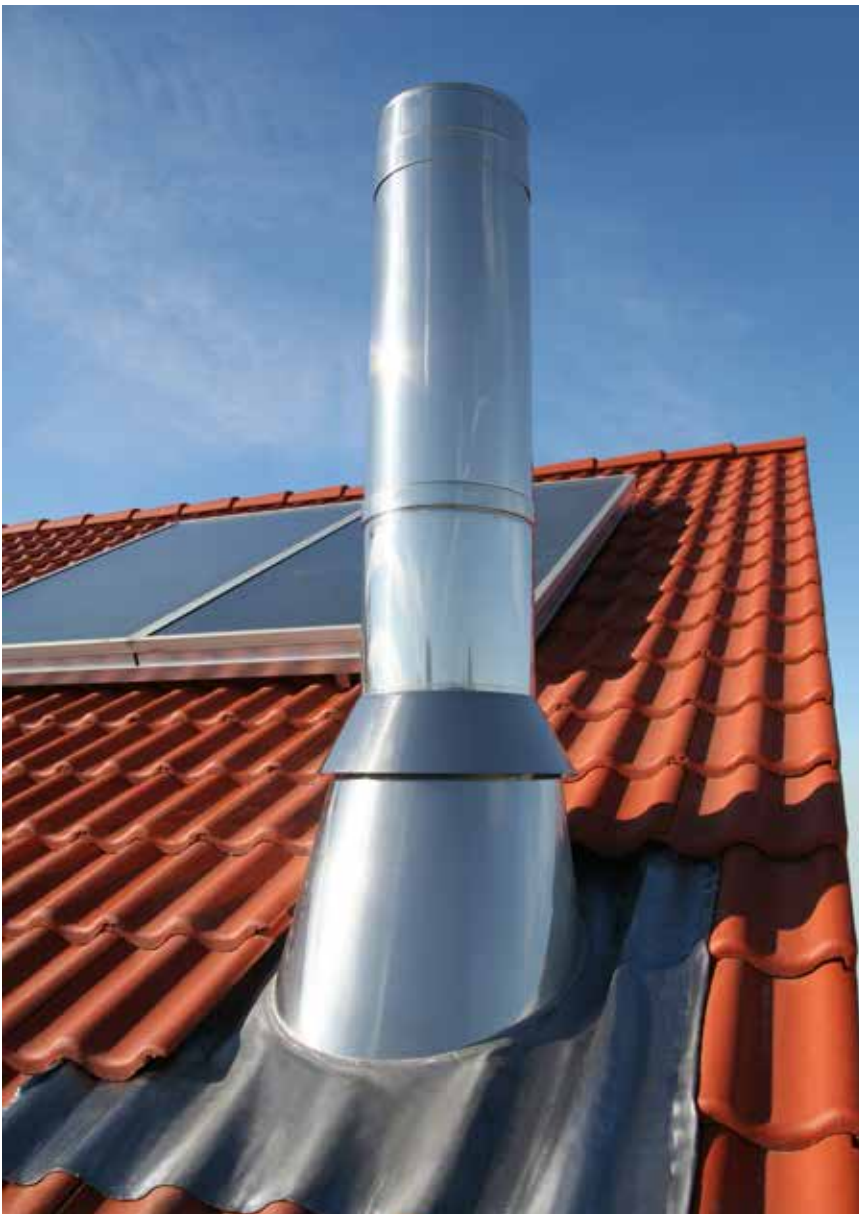
Bild 17: Die Hersteller von Abgasanlagen bieten spezielle Dachdurchführungen an, die Brandrisiken ausschließen. Foto: Schiedel, Wien (A)
