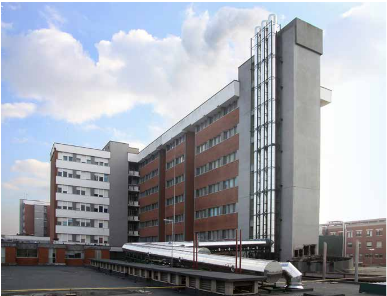
Bild 3: Doppelwandige wärmegeämmte Abgasanlagen im Außenbereich wurden ursprünglich als Renovierungslösung konzipiert. Foto: Roccheggiani, Camerano, Ancona (I)
