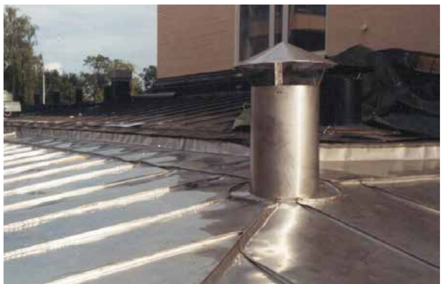
Bild 16: Wenn Abgasanlagen aus nichtrostendem Stahl Metalldächer durchdringen, gilt es die galvanische Verträglichkeit der Partnerwerkstoffe zu prüfen. Foto: Willem De Roover, Gent (B)
