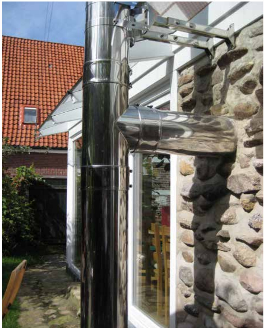
Bild 15: Zur Befestigung von Abgasanlagen aus nichtrostendem Stahl dürfen nur Befestigungsmittel aus nichtrostendem Stahl eingesetzt werden. Verzinkter Stahl kann in direktem Kontakt mit nichtrostendem Stahl galvanische Korrosion erleiden. Foto: Thomas Pauly, Brüssel (B)
