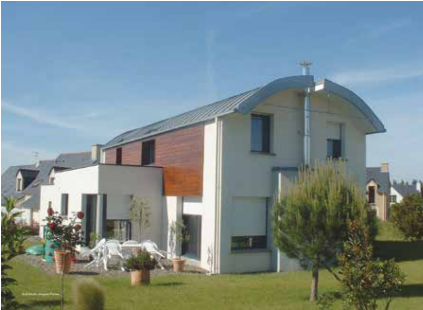
Bild 4: Zunehmend werden Abgasanlagen aus nichtrostendem Stahl im Außenbereich auch aus architektonischen Gründen eingesetzt. Foto: Poujoulat, Saint-Symphorien (F)
