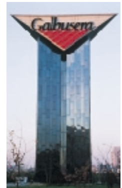
Das Firmensignet eines Süßwarenherstellers ist auf einem 22 m hohen Turm montiert, der mit elektrolytisch gefärbtem Edelstahl Rostfrei bekleidet wurde.
