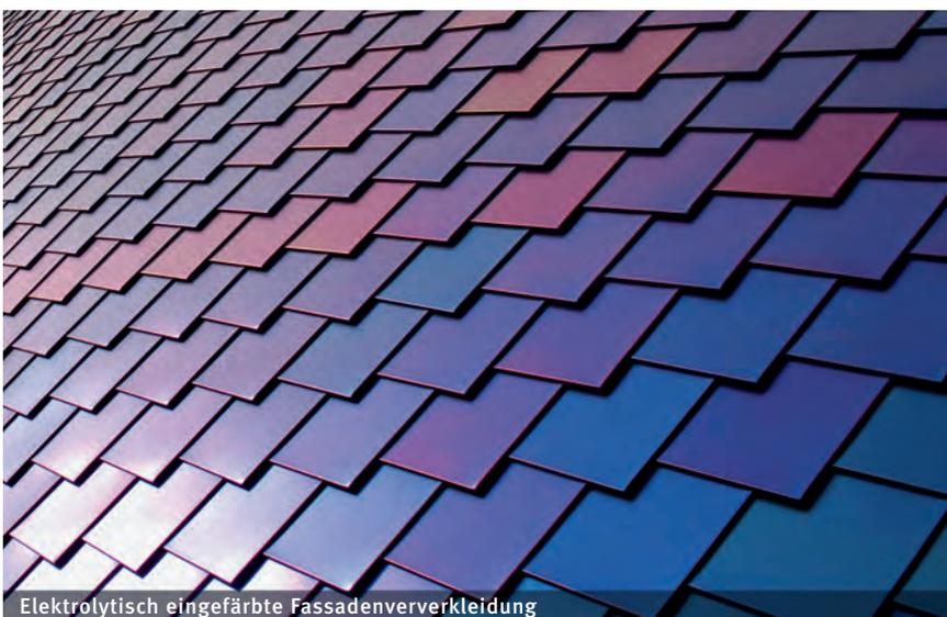
Elektrolytisch eingefärbte Fassadenverkleidung
