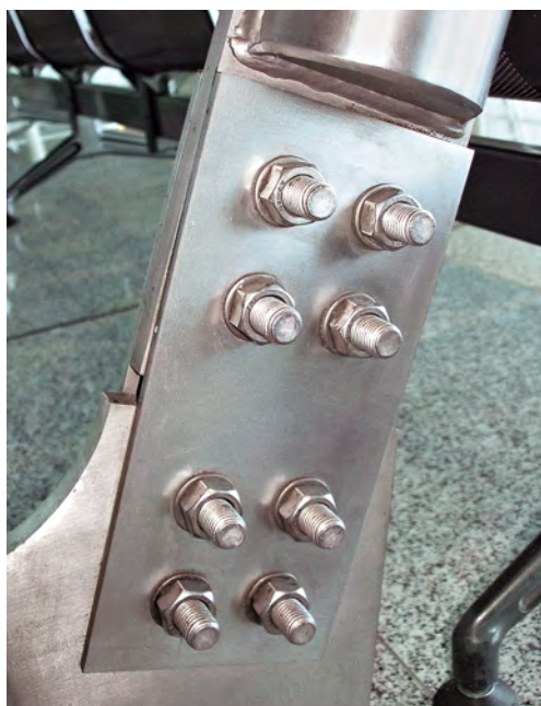
La boulonnerie utilisée pour l'assemblage de composants en acier inoxydable doit être de même nature que ceux-ci.
