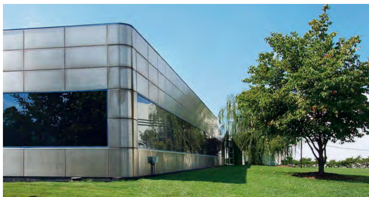
Façade en acier inoxydable avant et après nettoyage. Photo : York Property Company Inc., Bethlehem, PA (USA)
