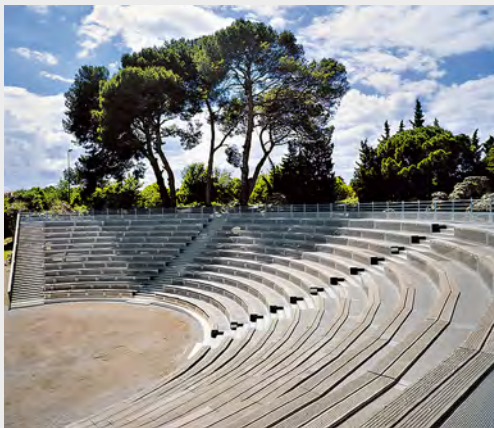
Les nouveaux gradins en acier inoxydable et teck suivent l'arc de la scène antique.
