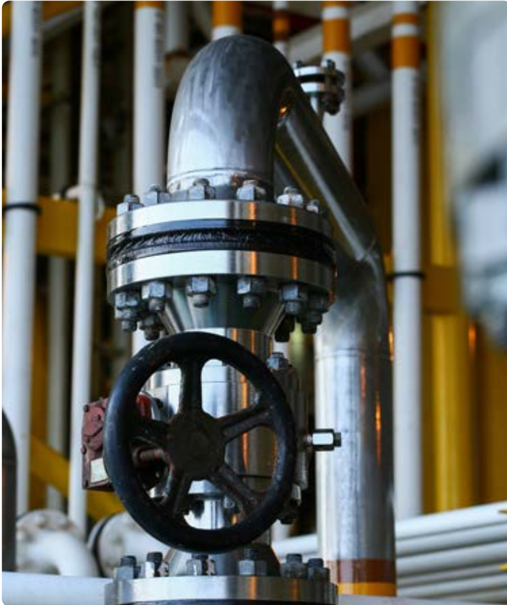
Handbetätigtes Ventil aus nichtrostendem Duplex-Stahl in der Öl- und Gasproduktion
