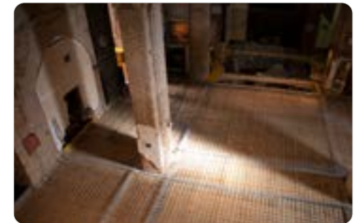
Nichtrostender Bewehrungsstahl im Boden der Kirche Santa Catalina, Spanien Foto: Cedinox
