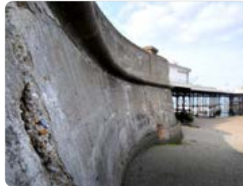
Küstenschutzmauer, Cromer, Großbritannien Foto: Archant/Anthony Kelly
