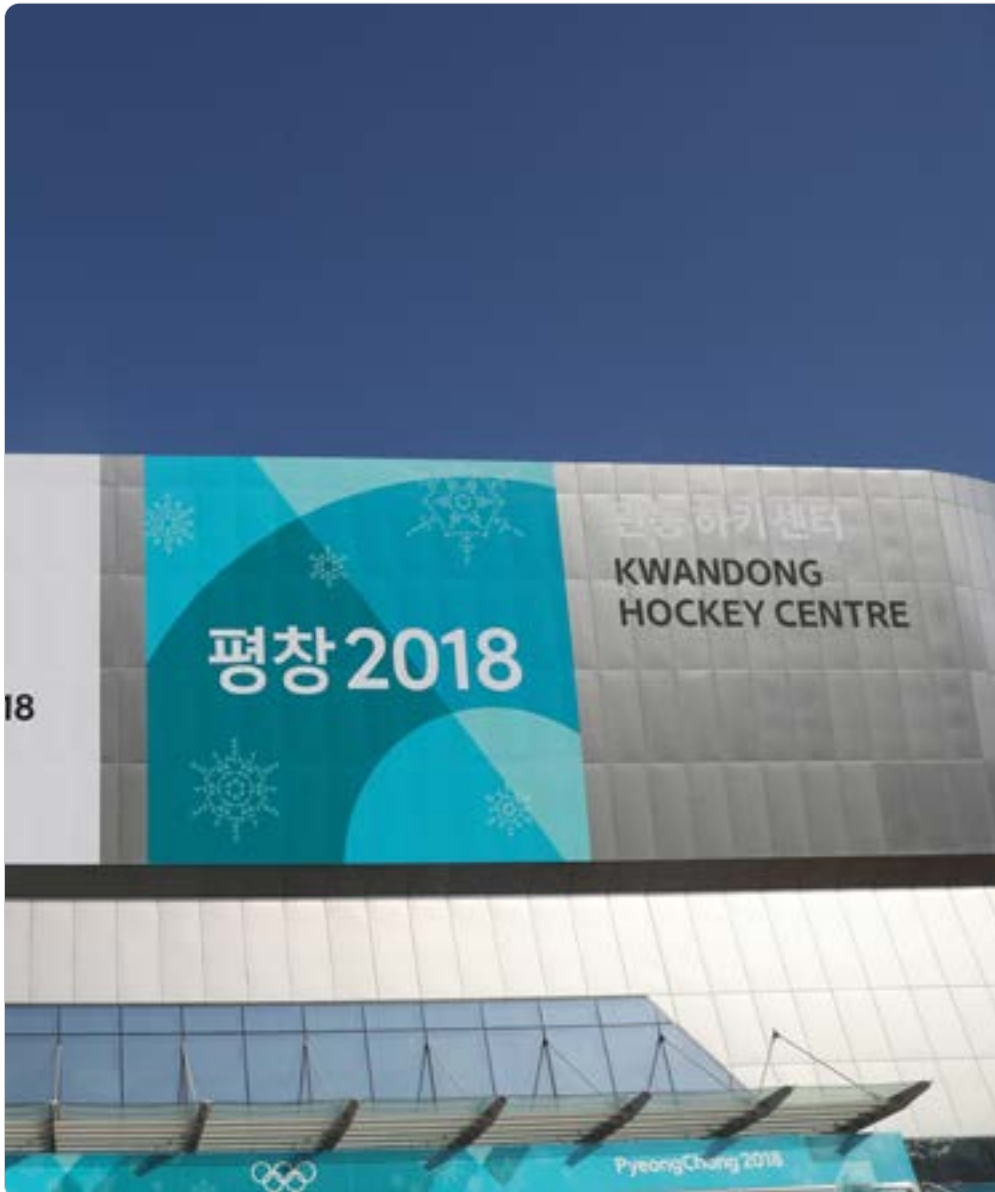
Detail des Kwandong-Eishockeyzentrums in Korea, bekleidet mit dem Lean-Duplex-Stahl 329LD
