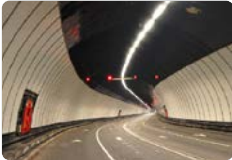
Auskleidung des Queensway-Tunnels, Liverpool, Großbritannien, Foto: Ancon
