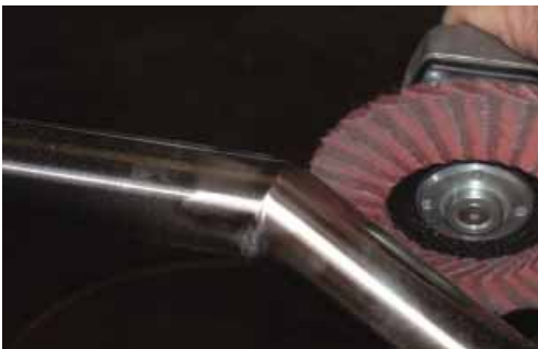
Bearbeitung der Außenseite mit einer Fächerscheibe
