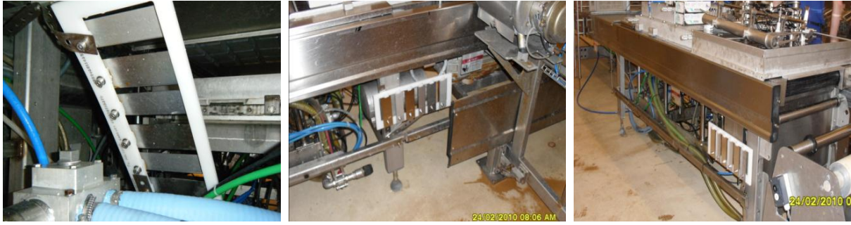
Abb. 8: Auslagerungen an Verpackungsmaschine Betrieb B
