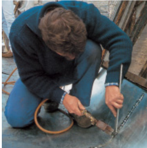
Foto: Brandt Edelstahldach GmbH, Köln
