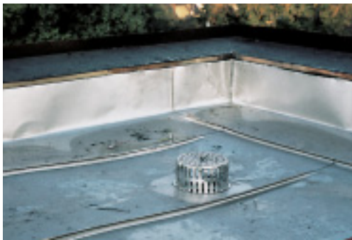
Auf Maß vorgefertigter Ablauf (oben), eingebauter Ablauf mit Laubfang (unten).
