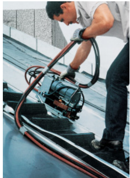
Rollnahtschweißmaschine mit wassergekühlten Elektroden.
