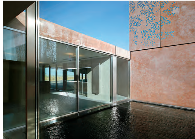
Raumhohe Verglasungen zum Innenhof sorgen für natürliche Belichtung der Büroräume.
