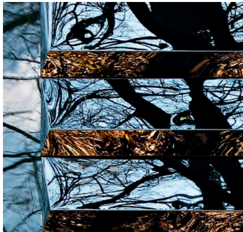
Auf den ersten Blick kaum wahrnehmbare Unterschiede der Paneelabmessungen tragen zur spannungsreichen Gestaltung der Fassade bei.
