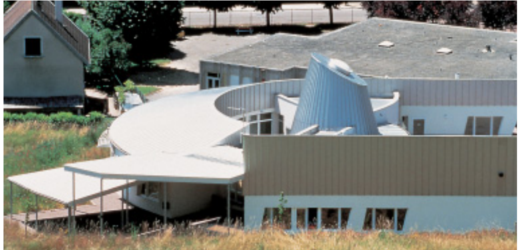
Bei Dacheindeckung und Verkleidung der hohen Attikazonen in der Fassade wurde dasselbe Material, mattgrauer Edelstahl Rostfrei, eingesetzt.
